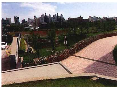
校舍興建時開挖所挖出的卵石 現以石籠形式作為牆體
